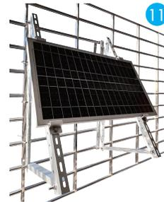
**Schritt 11** Überprüfen Sie die Stabilität der gesamten Halterung und des Solarmoduls und ziehen Sie ggf. noch lose Teile und Schrauben fest.
